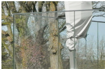
☑ Windschutzscheiben an Balkonen sind „unsichtbar“
