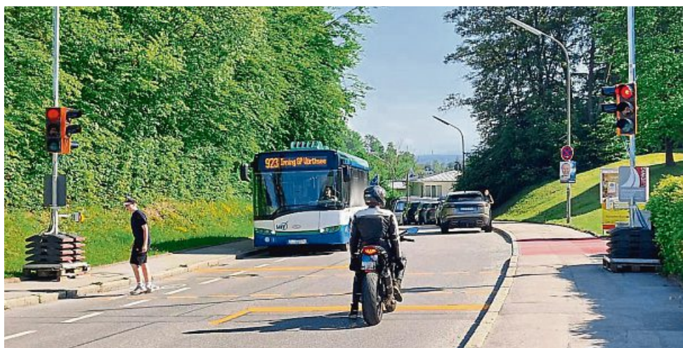
Lange ersehnt und nun endlich an richtiger Stelle auf Höhe der Kirche installiert: die neue Fußgängerbedarfsampel an der Etterschlager Straße in Steinebach. FOTO: HVP
