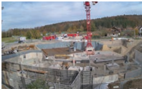
Baustelle neues Rathaus
